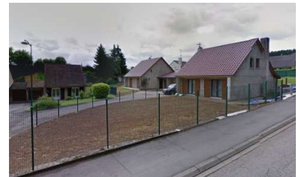
Clôture en grillage
