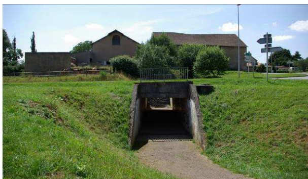
> Tunnel piéton-cycle passant sous la RD11 pour rallier la route d'Amanvillers ...
