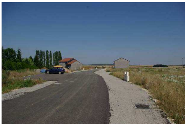
> Chantiers du nouveau lotissement du « clos de Chantrenne »
