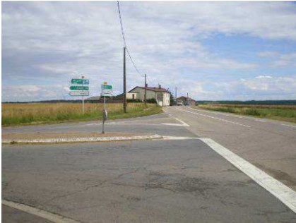
> Carrefour dangereux dans le secteur de Malmaison
