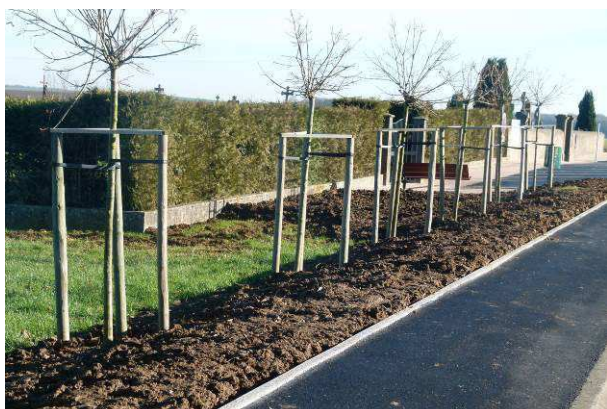
> Trottoirs rue de Chantereine récemment réaménagés à proximité du cimetière
