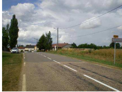
> Un profil très rectiligne pour l'entrée sud du village par la RD11 bis ...
