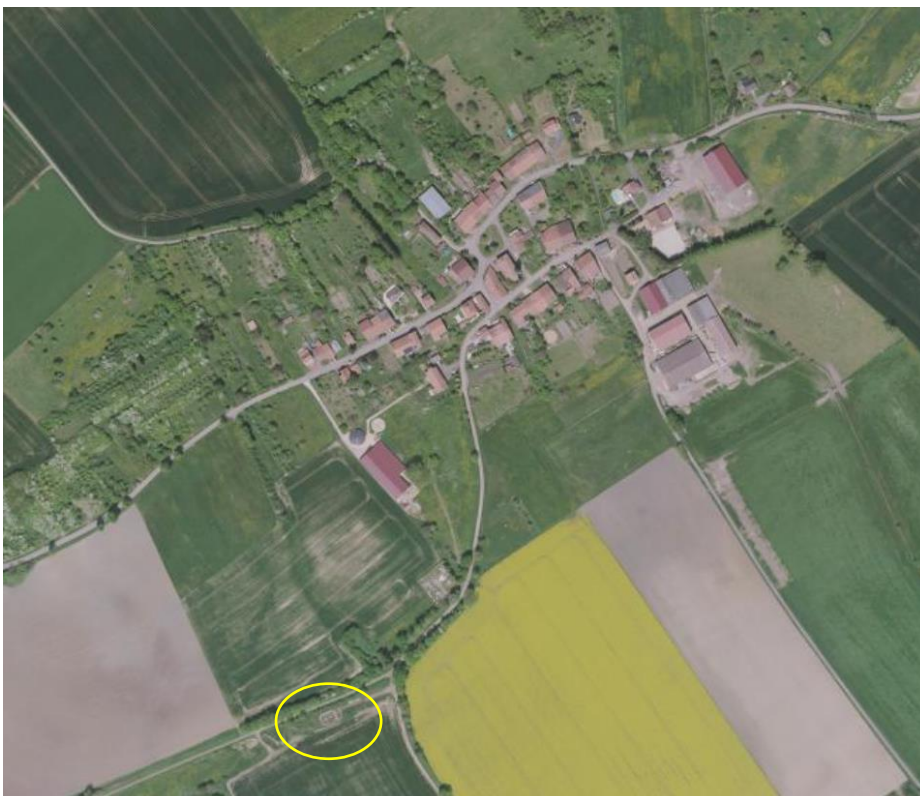
Localisation des filtres plantés de roseaux
