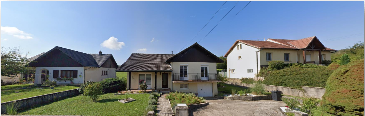
Pavillons, Rue du 26 Novembre 1944, photo : GoogleStreetview
