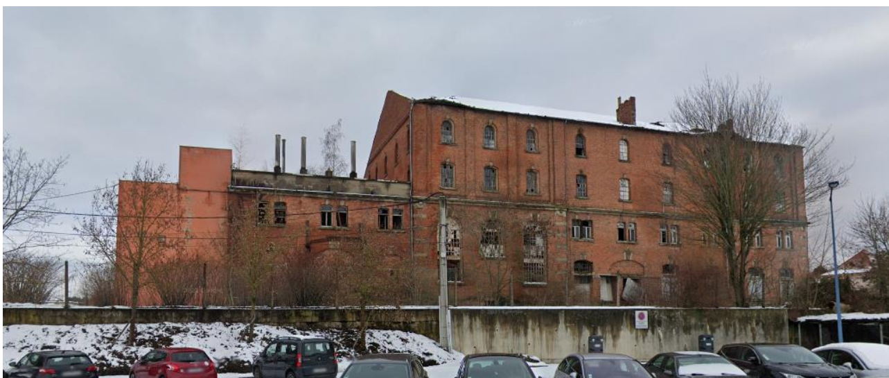
Friche de l'entreprise Samer depuis 1982
