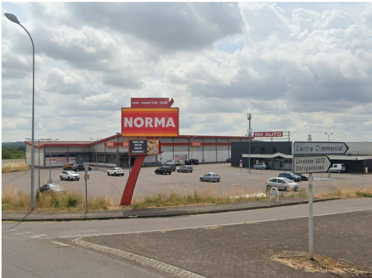
Supermarché Norma, Zone Artisanale et Commerciale de Folschviller - Valmont, (Source : Google Street View)
