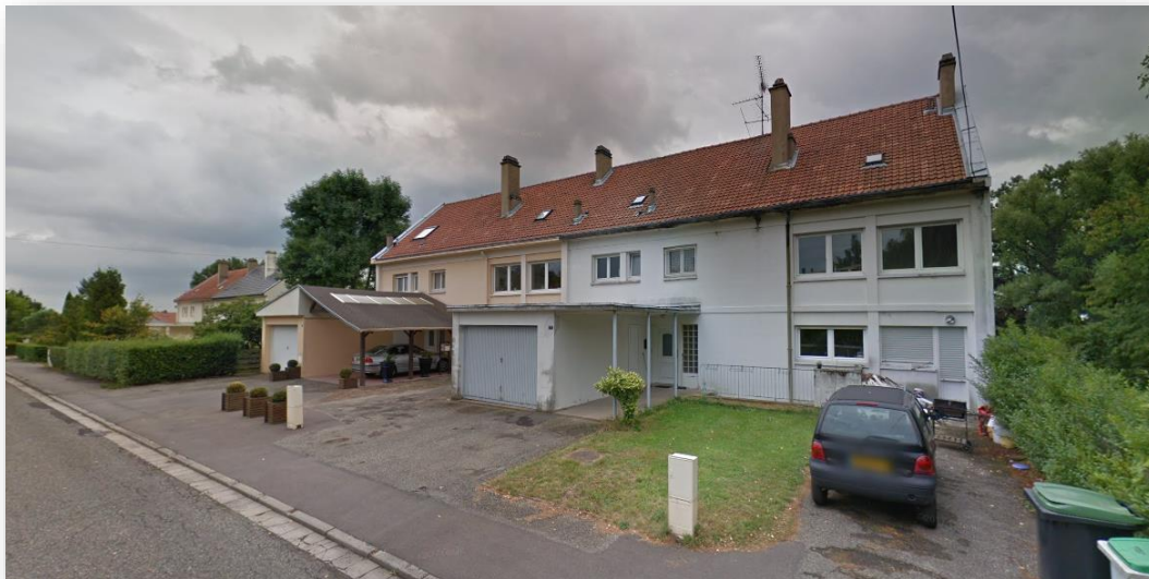
Cités, Impasse de Gorze, photo : GoogleStreetview
