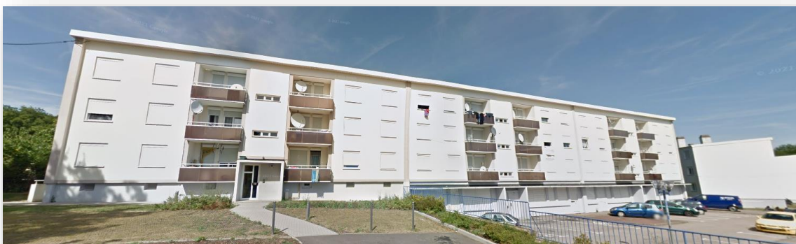
Collectifs, Rue A. Lamartine, photo : GoogleStreetview
