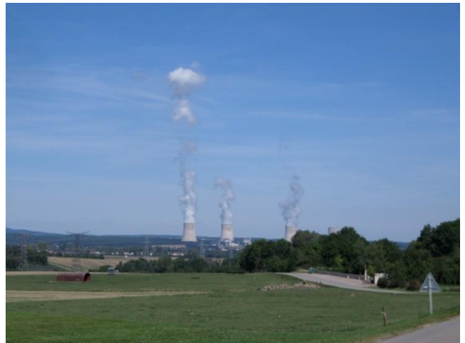
Vue sur les tours de refroidissement de la centrale nucléaire de Cattenom
