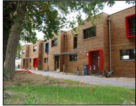
Exemple de maisons en bande à Vern-sur Seiche (35)
