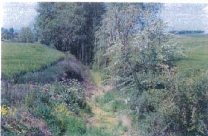
Le ruisseau du Pont de Misère, à entretenir, depuis le pont de la RD55h en allant vers Montrequienne
