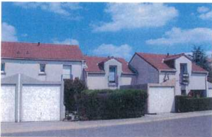
Maisons en bande, rue du Moulins
