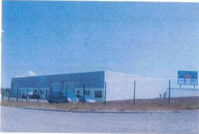
Le bâtiment relais de la Communauté de Commune
