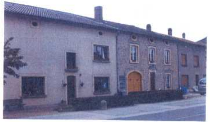
Anciennes fermes réhabilitées, Grand Rue
