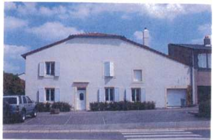
Maison réhabilitée, place de la Mairie
