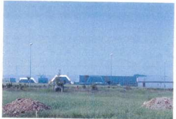
Le bâtiment des sociétés CERP et CAP logistique
