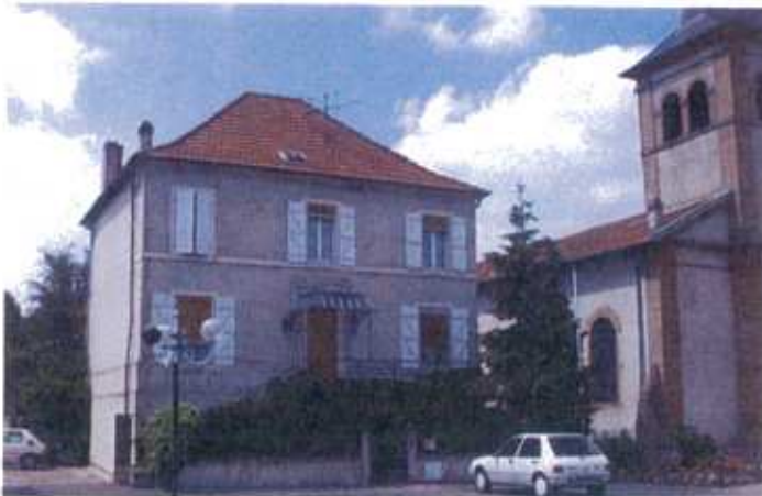
Maison place de la Mairie, à côté de l'église
