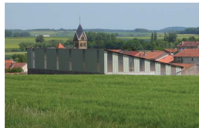
Hangar récent, à structure et bardage métallique
