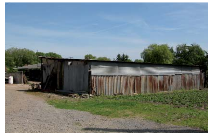
Hangar peu entretenu, à structure et bardage métallique
