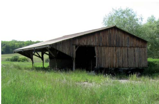
Beau hangar à structure et bardage bois (Poncillon)
