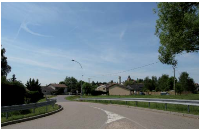
3. Nouvel accès à Sorbey à travers la zone inondable
