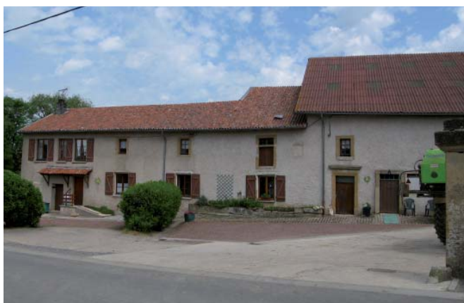
Gîtes ruraux rue du Moulin, en retrait de l'alignement
