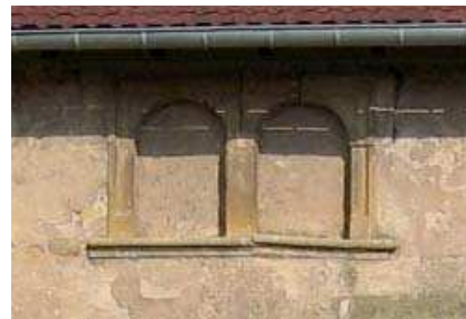
Baie géminée détail de la maison forte
