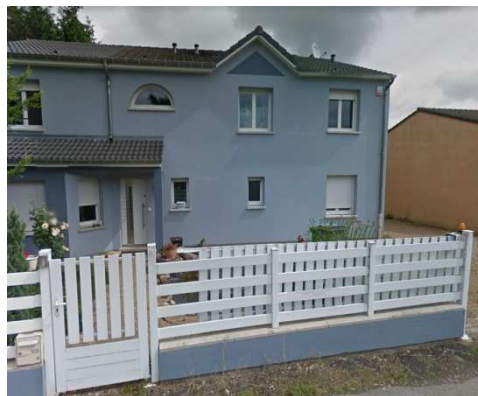
Clôture à claire-voie
