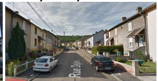
Bâti mitoyen rue Dejonc – source : Street View
