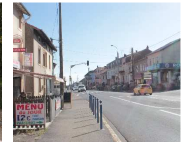
Rue De Gaulle avant travaux
