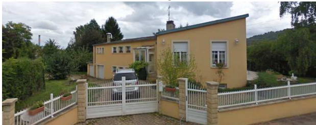
Maisons rue des Acacias – source : ITB, 2017
