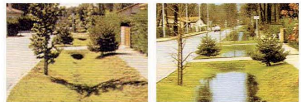
Noues de stockage et d'infiltration des eaux dans un lotissement (Bois-Guillaume, agglomération de Rouen)
