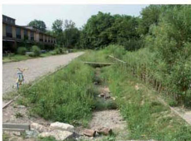
Noues de stockage et d'infiltration des eaux à Ariesheim (agglomération de Bâle, CH)
