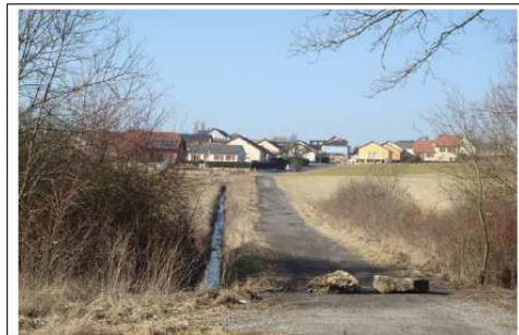
Traitement du cheminement et du fossé de liaison entre le Sud de la trame urbaine et la forêt
