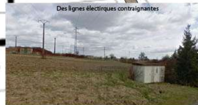
Des lignes électriques contraignantes
