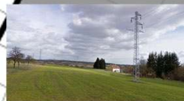
Vue sur le site et la ligne électrique
