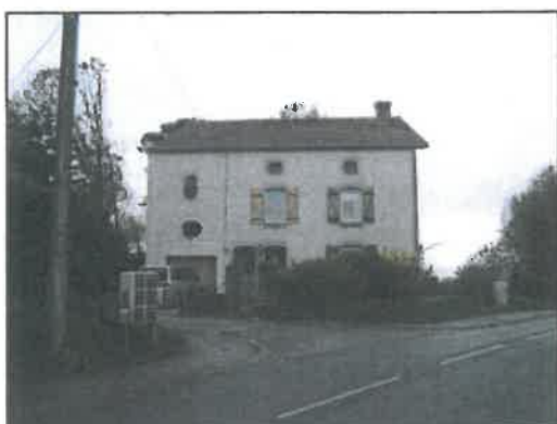
Maison rénovée à SAINT EPVRE
