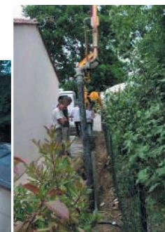
Figure 26 Écran en béton classique. Tranchée de 30 cm remplie de gros béton (Source Socabat)
