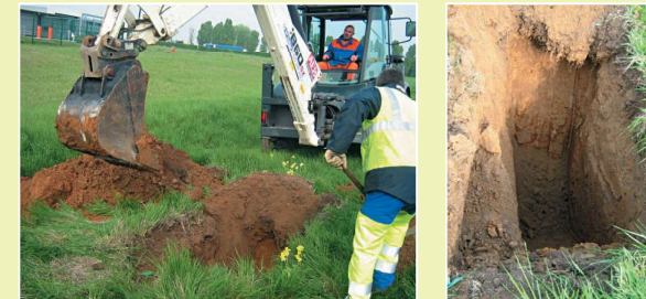
Sondages à la pelle mécanique dans des matériaux limoneux (Source Cerema)
