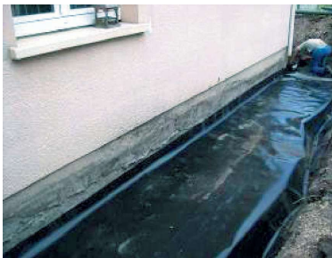
Figure 22 Géomembrane en cours de pose (Source Socabat)
