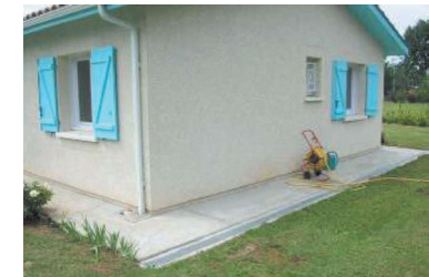
Figure 20 Large trottoir avec caniveau de collecte des eaux de ruissellement (Source Socabat)
