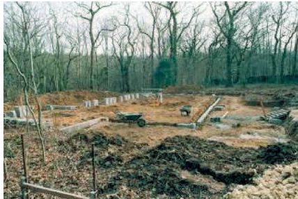
Figure 17 Comment les arbres ont-ils été dessouchés ? Le maçon le sait-il et a-t-il prévu en conséquence la bonne profondeur d'assise ? (Source Socabat)
