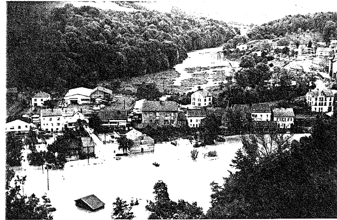
en rive droite, la RN 3 sous les eaux
