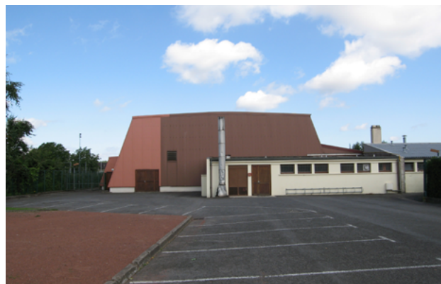
Gymnase: bardage métallique et vestiaires maçonnés
