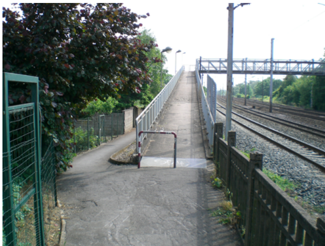
La passerelle au-dessus du chemin de fer
