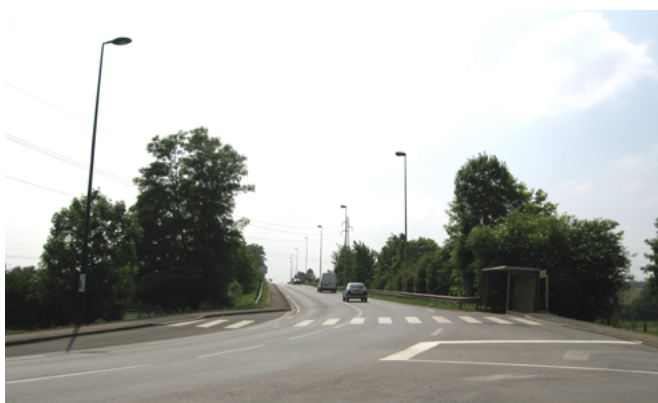
Passage de la R.D.54 au-dessus de la voie ferrée
