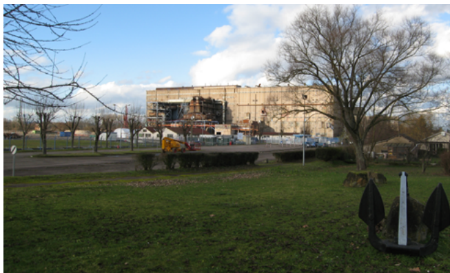
La centrale électrique depuis l'écluse
