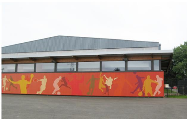
Tennis couverts après rénovation
