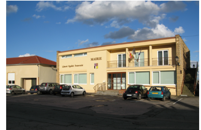
Mairie (et petite salle des fêtes à gauche, ancienne Poste)
