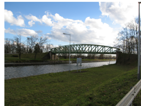
La Moselle canalisée : passerelle de la véloroute
