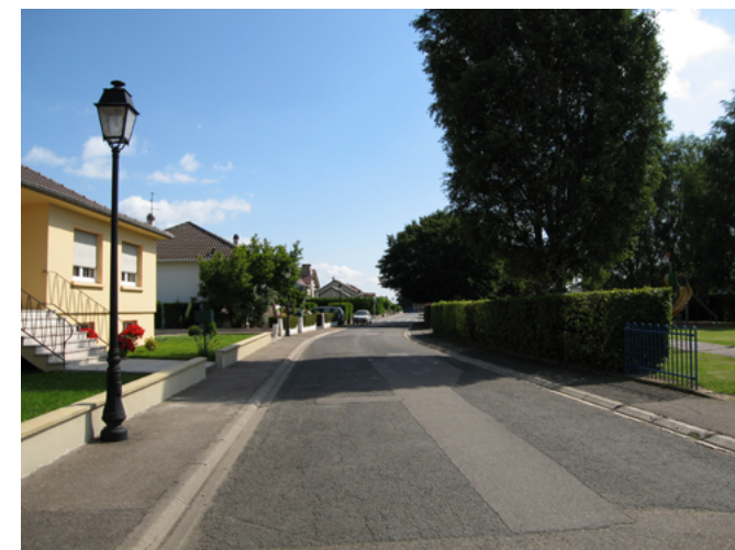
Lotissement du Berg 2 de tranche, rue des Alouettes
