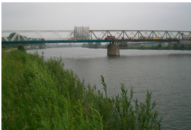
Le pont de la RD60 sur la Moselle, récemment rehaussé pour augmenter le tirant d'air des péniches à grand gabarit
