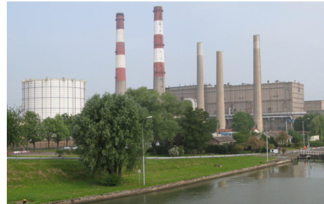
La centrale sidérurgique, avant déconstruction
