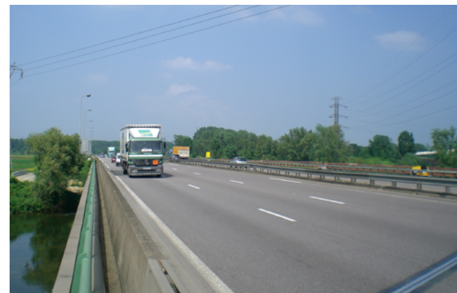
Autoroute A31 au-dessus de l'Orne
