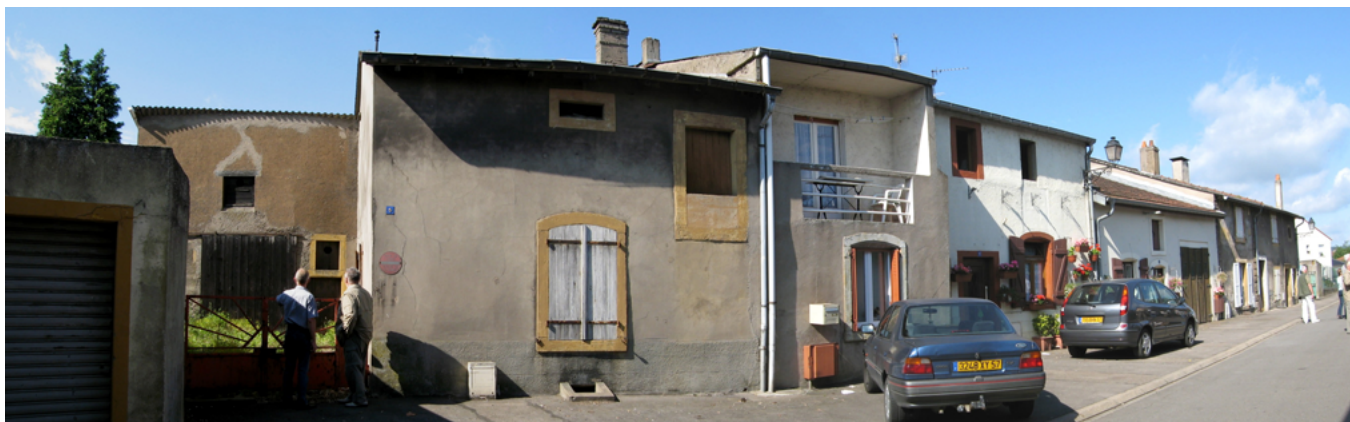
Alignement rue du Bois
