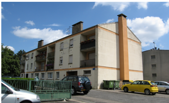
20 logements communaux, rue des Jardins
