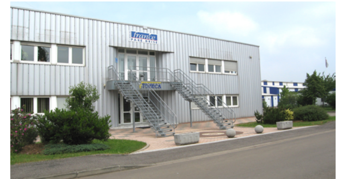
Bardage métallique dans la zone artisanale
