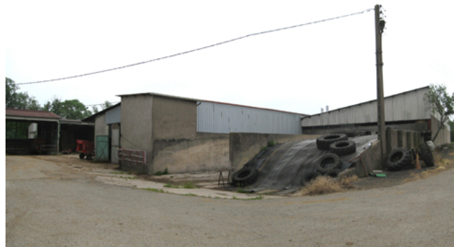
Hangars agricoles de la ferme de Pépinville
