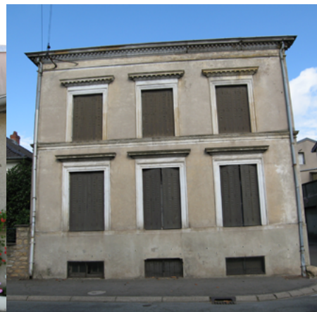
Maison de ville dans la Grand'Rue
