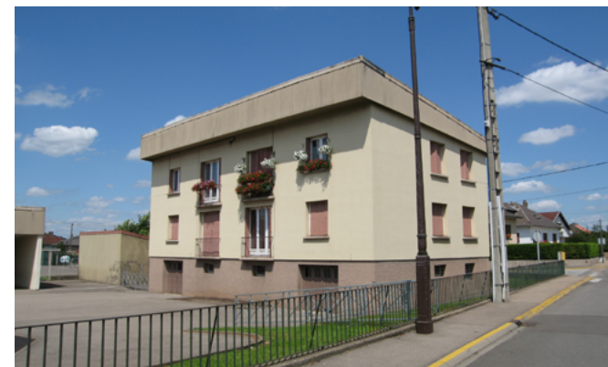
4 logements communaux, rue Saint-Jacques
