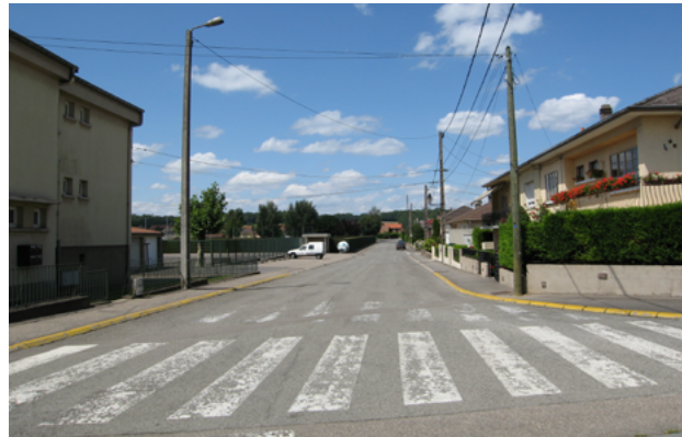
Une voie sur-dimensionnée, rue du Stade
