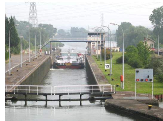
La Moselle canalisée : écluse
