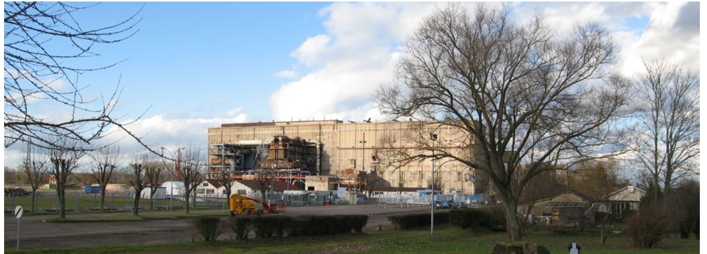
La centrale électrique en cours de déconstruction depuis l'écluse sur le canal de la Moselle
