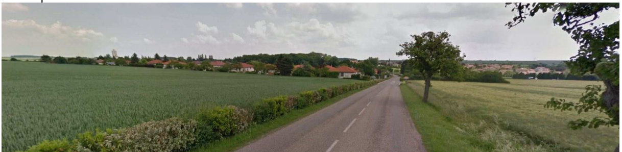
Vue de l'entrée Nord de la commune, depuis la route départementale RD154A
