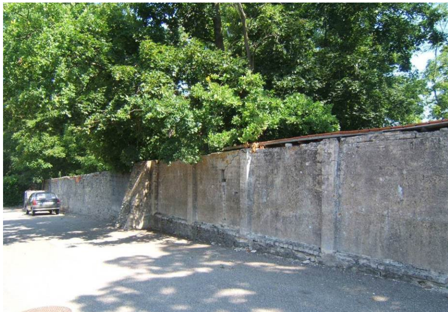
Le parc du château, un espace enclavé derrière ses longs murs d'enceinte
