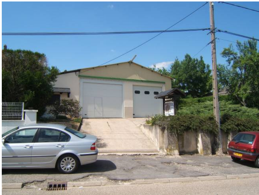
Bâtiment d'activités inséré dans le tissu urbain (Rue de METZ)
