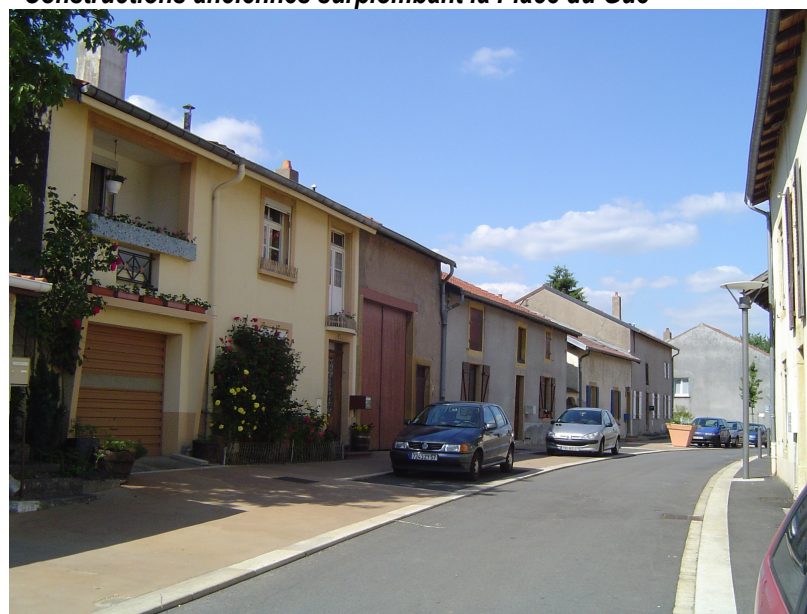
Constructions anciennes implantées en ordre continu et en retrait d'alignement par rapport à la voie (Rue des Fontaines).
