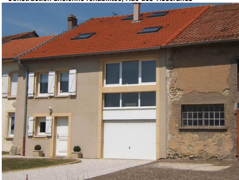
Construction ancienne réhabilitée, Rue des Fontaines
