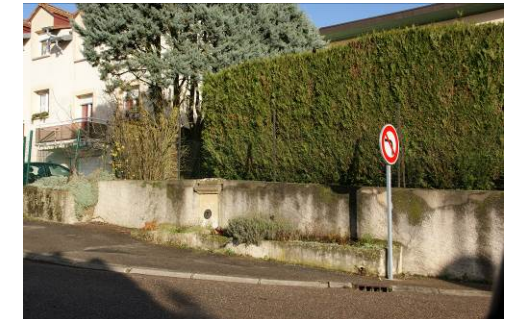
Muret en pierre
