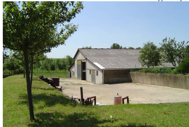
Exploitation agricole, Route de Colligny
