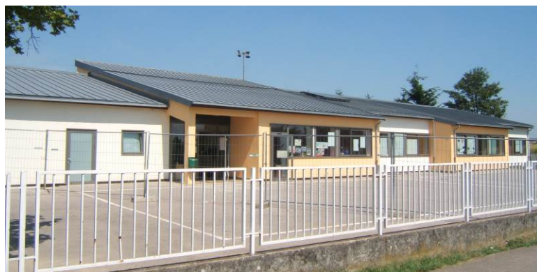
Bâtiment du centre scolaire (Rue de Lombez)
