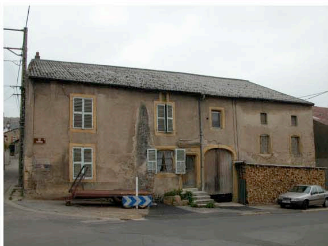
Maison de type lorrain, rue de Verdun
