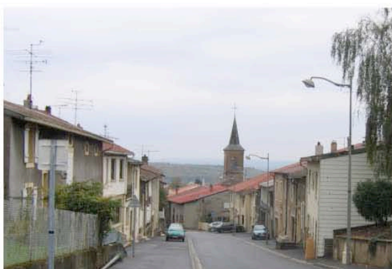
Alignement rue de Verdun
