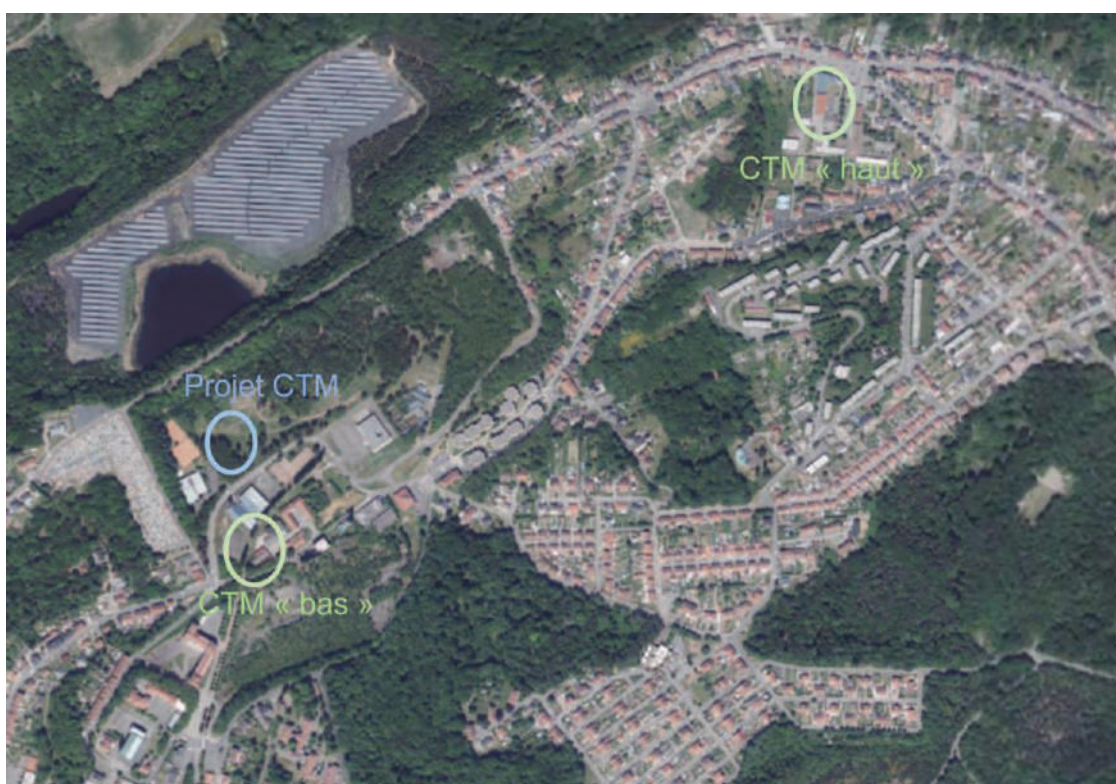
Positionnement actuel des ateliers municipaux - Photo aérienne (document Géoportail)
