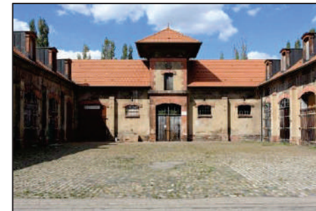
Anciennes écuries des Houillères (1856).
