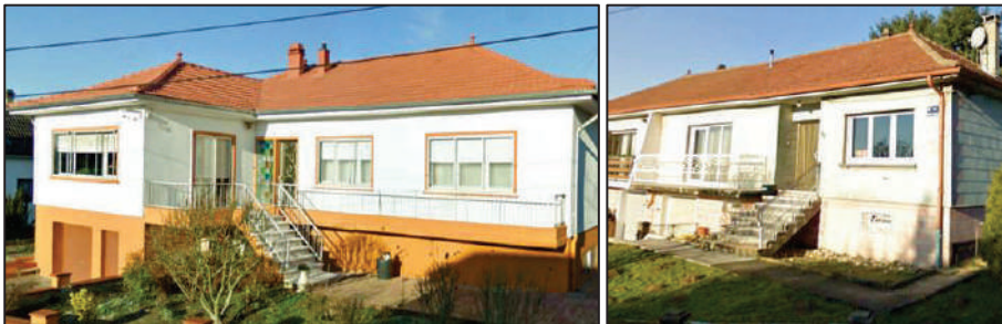
Exemples de constructions où le logement est situé à l'étage, pouvant engendrer à terme des problèmes d'accessibilité.
