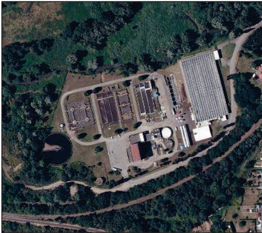
Station d'épuration de Forbach-Marienu.
