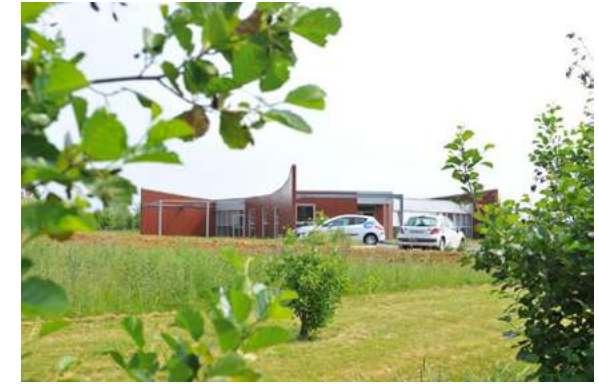
Autre bâtiment implanté sur l'Ecoparc
