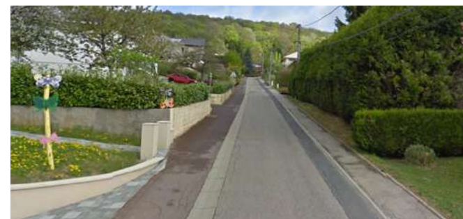
Voie interquartiers - RD50 – rue de Charreau
