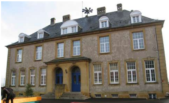
Ecole: une haute toiture à croupes couverte d'ardoises
