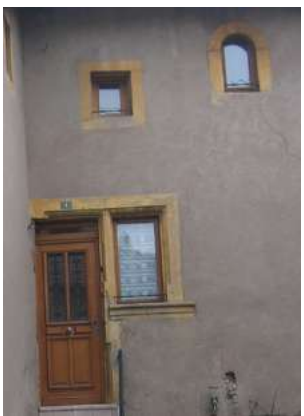
Ancienne fenêtre à meneaux Renaissance coupée par une porte récente
