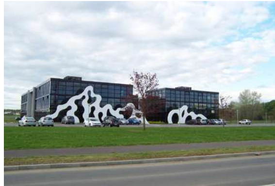
Bâtiment Le Meltem, implanté sur l'Ecoparc
