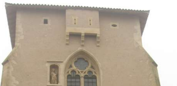
Détail d'un hourd au-dessus d'une baie gothique en ogive
