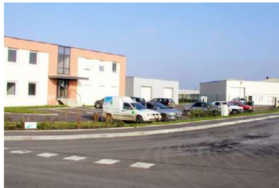
Bâtiments implantés sur la zone Euromoselle Sud
