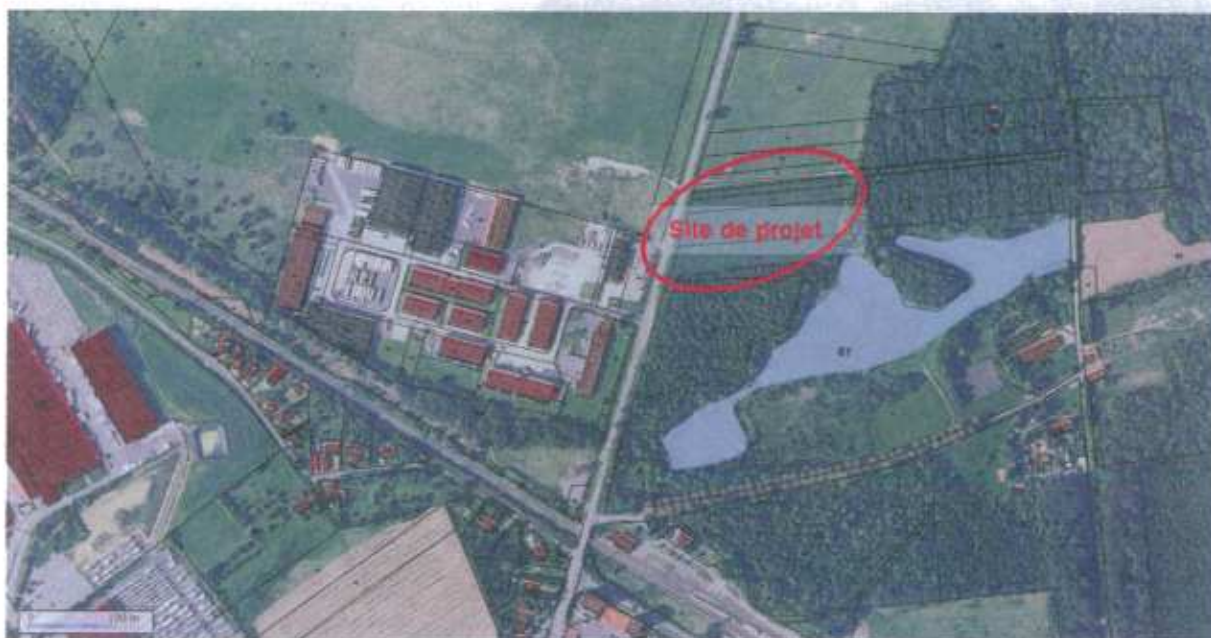
Localisation (source Géoportail)
