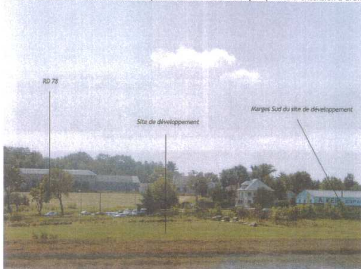
Vue sur la limite Nord du site de développement
