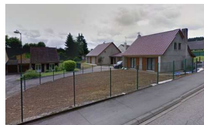
Clôture en grillage
