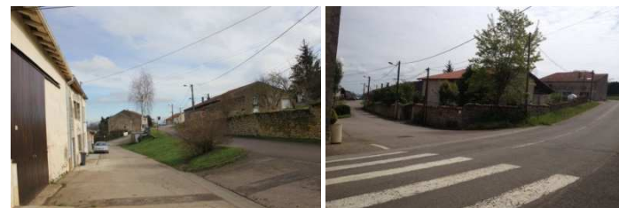
Rue de l'Église, voirie en impasse qui donne sur la D75A
