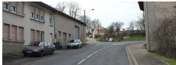
Route de Tragny dans la partie nord de Moncheux
