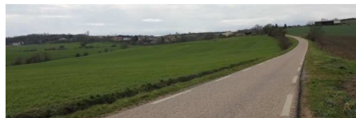
RD75A traversant les espaces agricoles (Route de Tragny). La voirie étroite et ne comporte pas de marquage central. Les véhicules sont obligés de ralentir lorsqu'ils se croisent.
