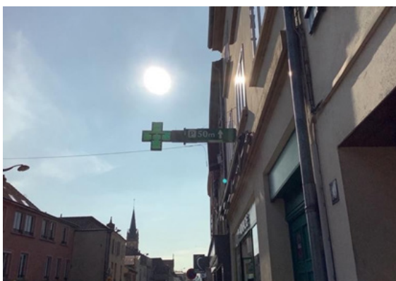
Figure 77 : Enseigne perpendiculaire présentant une saillie supérieure à 1 m (enseigne a priori non conforme au RNP), Longeville-lès-Metz, printemps 2021
