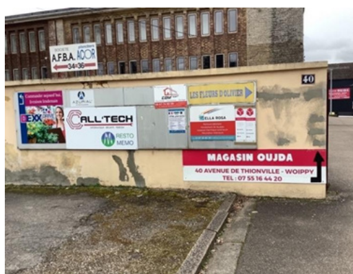
Figure 59 : Densité excessive de publicités sur un mur de clôture aveugle (supports a priori non conformes au RNP), Woippy, printemps 2021
