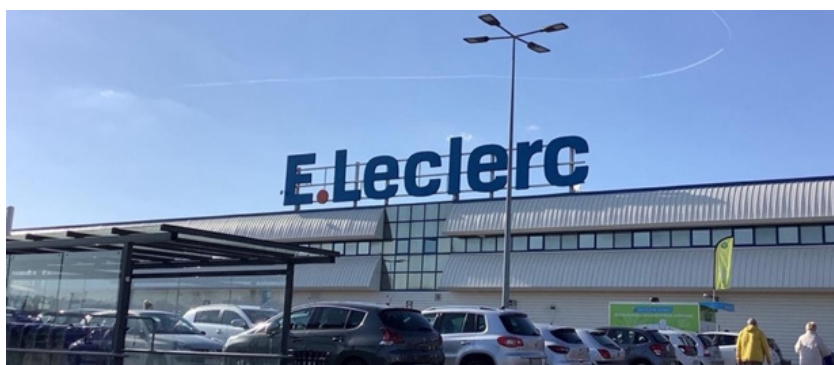
Figure 98 : Enseigne sur toiture de grand format présentant des lettres découpées, Marly (enseigne a priori conforme au RNP), printemps 2021
