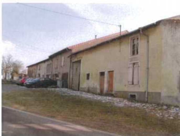
Mais de nombreux bâtiments restent encore à rénover ou restaurer
