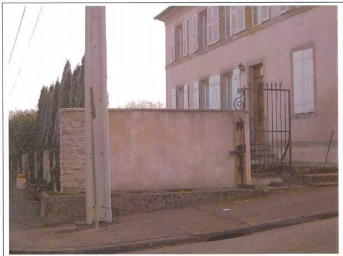
Les anciennes fontaines en centre ancien, près du Presbytère et près de la mairie
