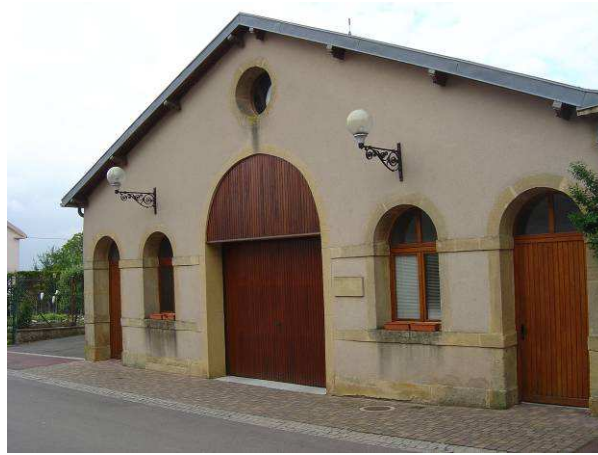
La caserne des sapeurs pompiers dans une ancienne maison rénovée
