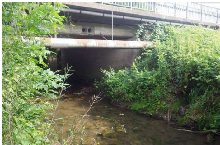
Le passage de l'Oudrenne au niveau de la RD654
