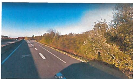
Echangeur autoroutier en direction de la RD654 vers la Mosparc Nord
