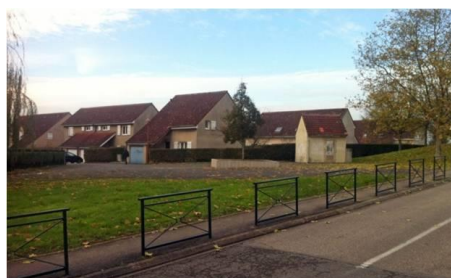
Voirie avec trottoir protégé par du mobilier urbain
