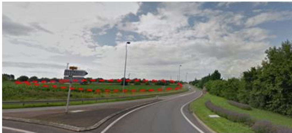
Vue depuis le rond-point Nord d'Illange (D1), le site de projet se situe à gauche de la voie, dans la zone de loisirs et de sports.
