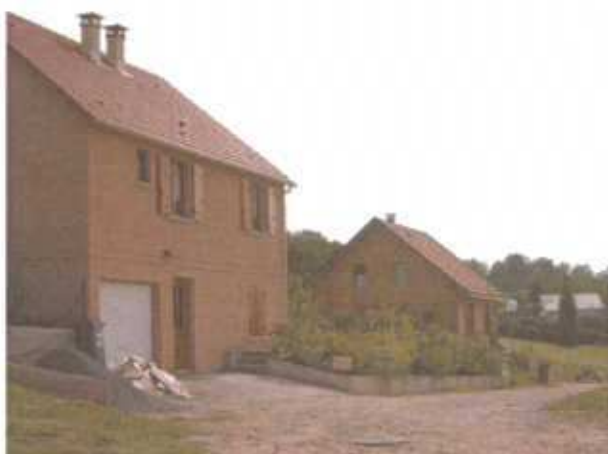
un petit lotissement (5 pavillons) est en cours de réalisation, rue Paul Pignon,
