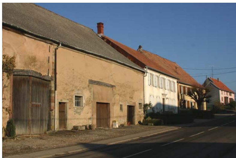
Rue Principale – partie haute
