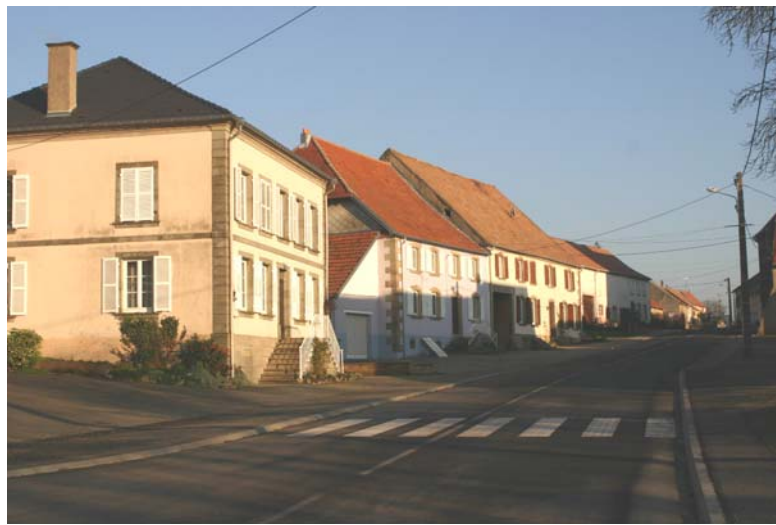
Rue Principale - partie basse, bâti continu et parallèle à la rue
