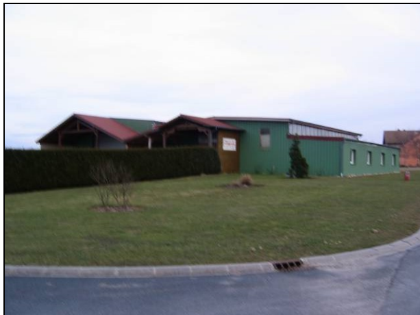
Entreprise de charpente et couverture, route de Waltembourg.
