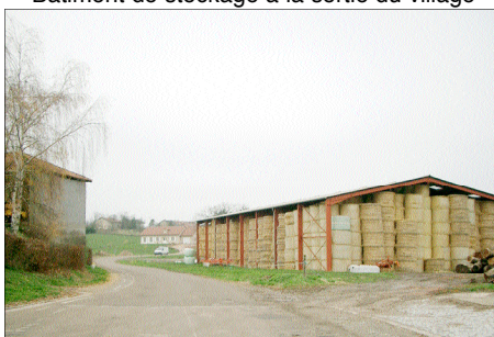
Bâtiment de stockage à la sortie du village
