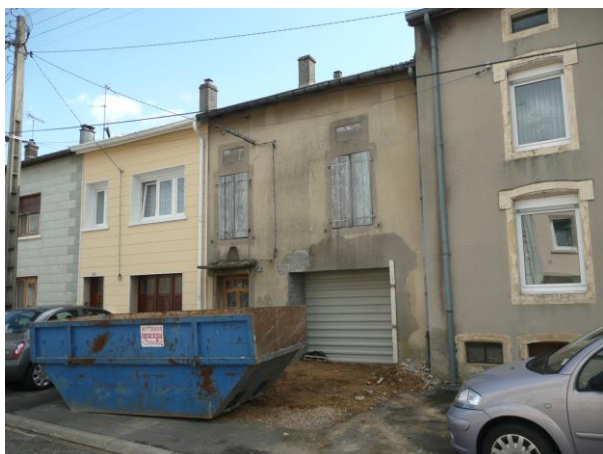
Habitation en rénovation
