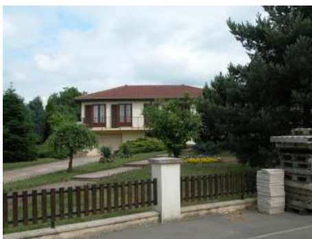
Maison individuelle, impasse de la Distillerie
