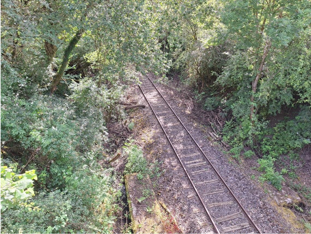
Couvert arboré aux abords du pont (ESTERR)
