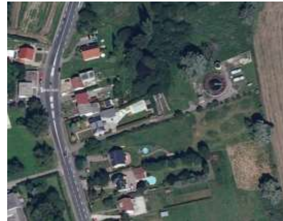
Vue aérienne de la station d'épuration de Grosblierstroff.
