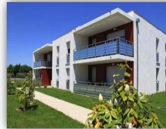
12 logements sociaux intermédiaires à Tournefeuille
