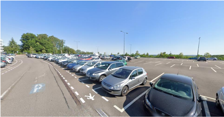
Parking de l'hôpital Sainte Madeleine : un enrobé sans qualité
