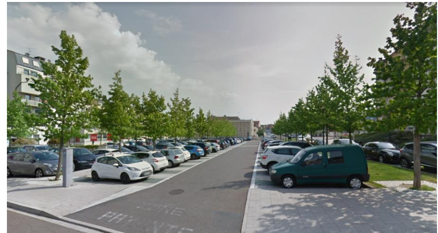
Place Johann Fischart : Traitement qualitatif d'une zone de stationnement au moyen de revêtements de sol différenciés et de végétation (arbre et pelouse)
