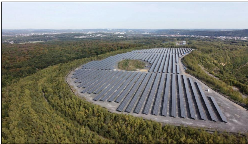
Figure 41 : Parc photovoltaïque du terriil Wendel (Source : www.republicain-lorrain.fr )
