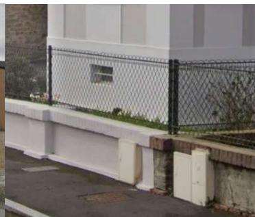
Muret surmontée d'un grillage de type bordure parisienne ronde
