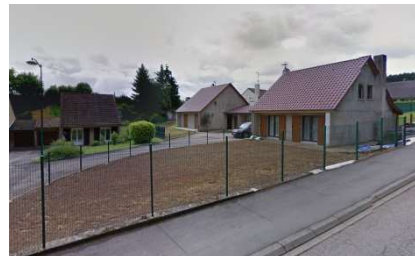
Clôture en grillage
