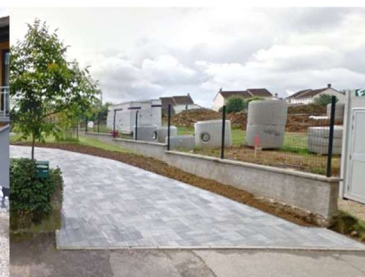
Muret surmontée d'un grillage
