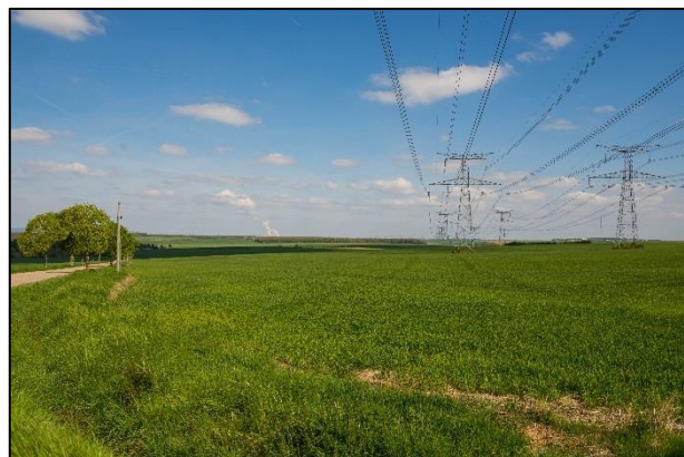
Vue au pied des lignes à haute-tension situées au point le plus haut (sud-est de FLEVY). En arrière-plan se devinent, par temps clair, les tours de la centrale nucléaire de Cattenom.
