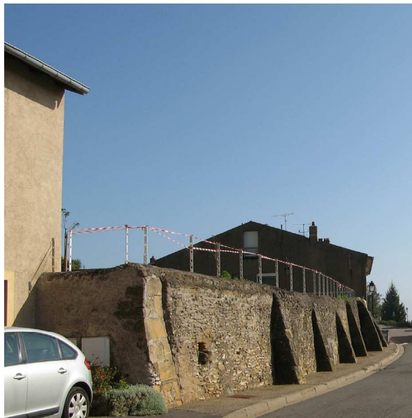
Mur de soutènement en pierre
