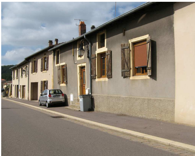
Alignement rue Haute
