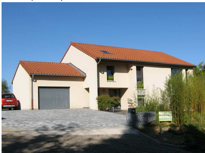
Construction diffuse - Rue de Verdun
