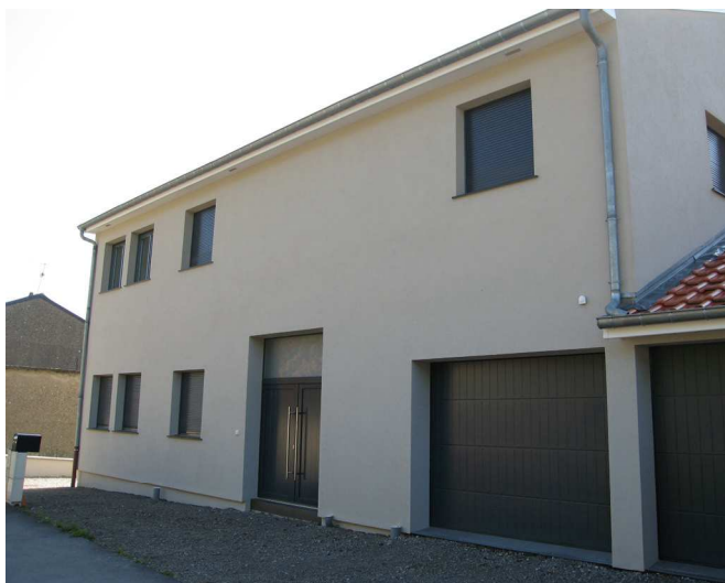
Construction dans une dent creuse - D 112B
