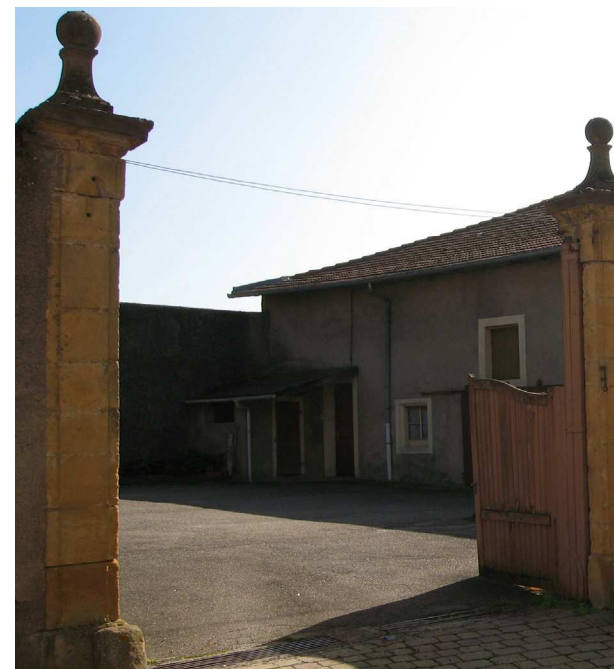
Entrée bordée par des piliers surmontés d'un couronnement
