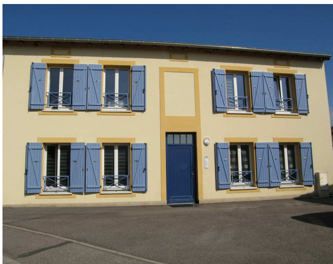
Rénovation rue du Quaraille
