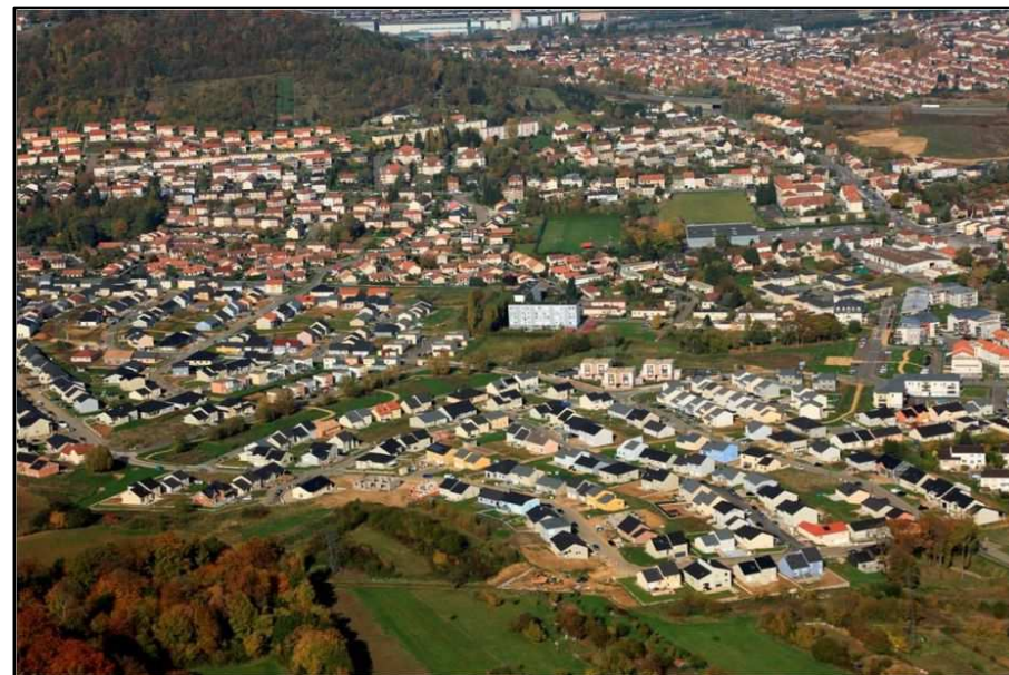
Vue aérienne de la ZAC du Domaine de la forêt après réalisation
