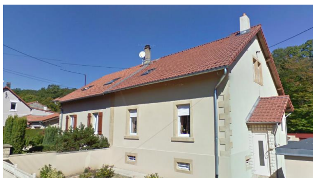
Cités ouvrières jumelées, rue de la Sapinière / rue de la Mine. La taille modeste et l'architecture peu travaillée est compensée par l'harmonisation du quartier dans son ensemble.
