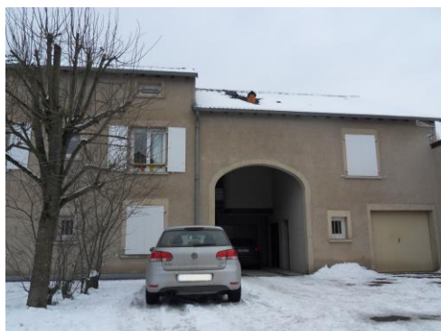
Rue du Général de Gaulle. Certaines habitations jointives affichent en façade quelques pastiches de la ferme lorraine traditionnelle, avec notamment la grande ouverture de la grange.
