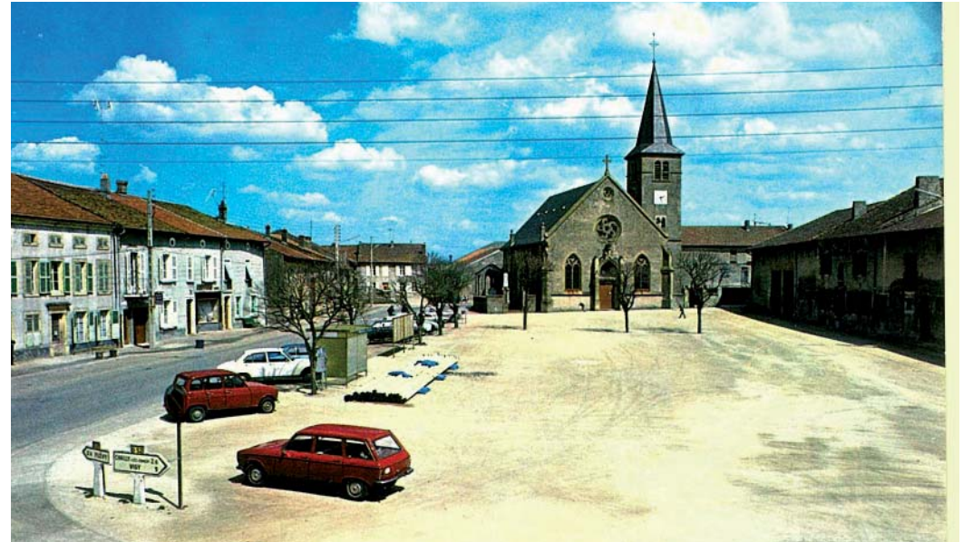
Carte postale de la place Robert Schuman avant travaux
