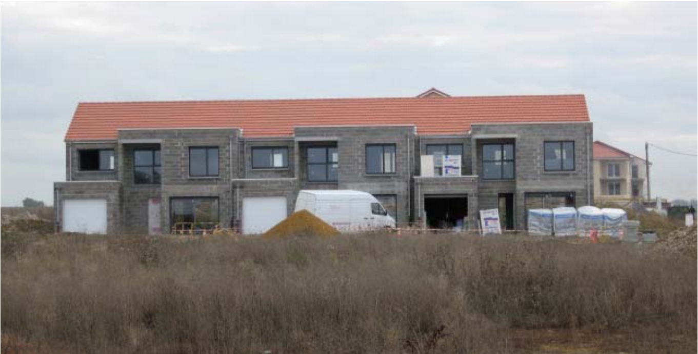
Maisons en bande sur la ZAC de Bégnennes
