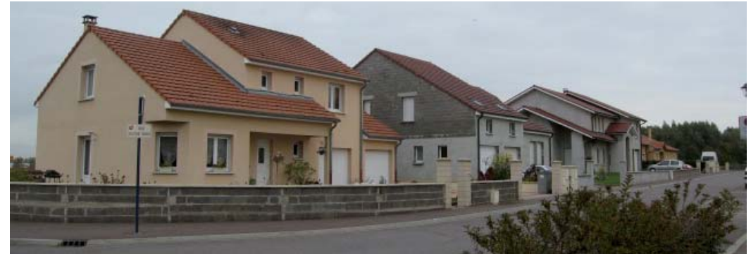
Nouvelles constructions Rue Victor Hugo
