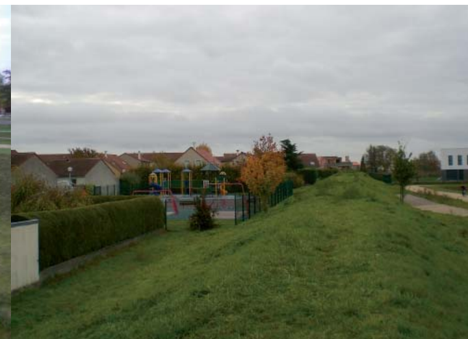
Merlon anti-bruit protégeant le lotissement du Poirier le Loup
