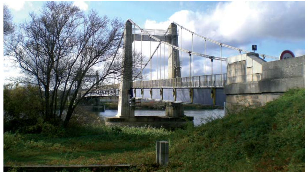
Pont de l'ingénieur Rapilly entre Hauconcourt et Ennery
