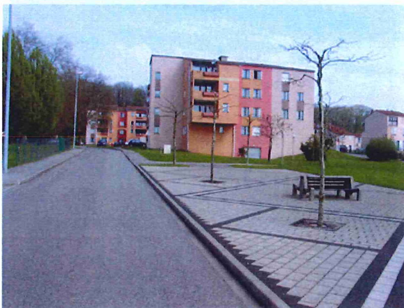
La cité Maroc composée d'une partie ancienne avec des maisons individuelles mitoyennes, caractéristique des cités ouvrières, et une partie plus récente composée d'immeubles collectifs.
