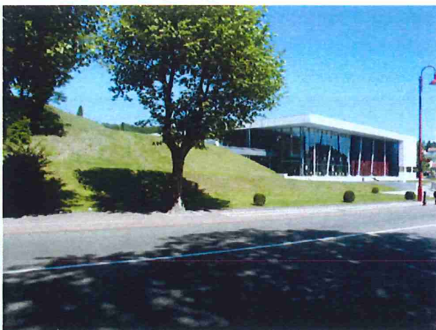
La salle polyvalente: une architecture moderne.
