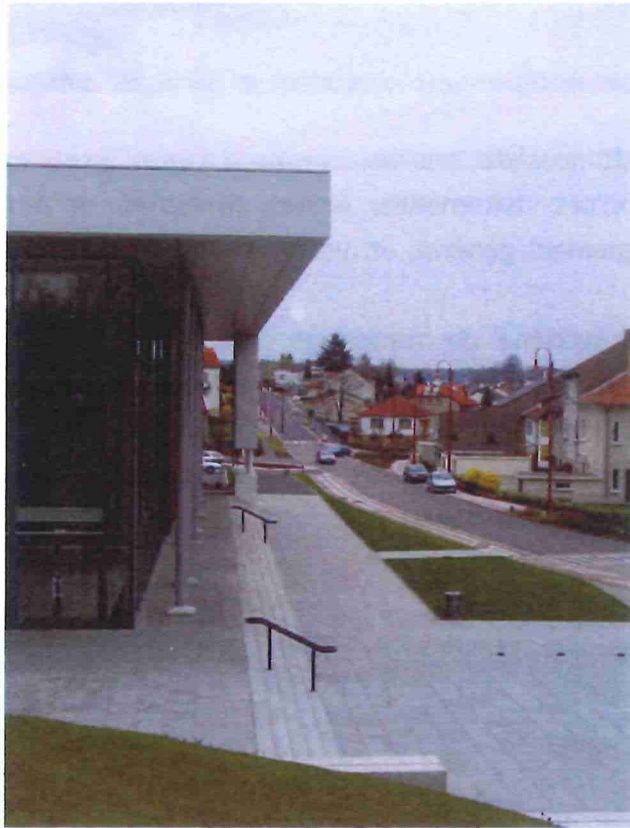
La nouvelle Salle polyvalente.
