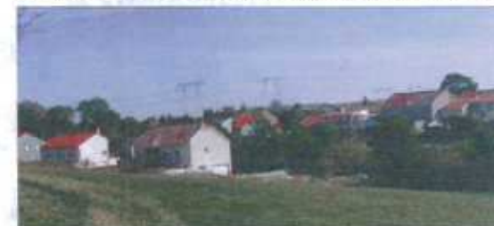
Les lignes électriques passant à proximité du village
