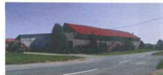
Colombey : la ferme vue depuis la RD4
